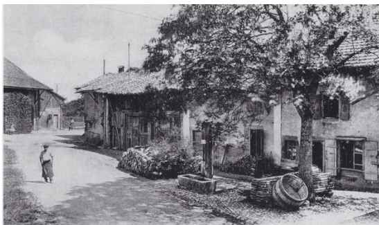
Chemin du Vuillonnex N° 69-65 et 40, vers 1900
