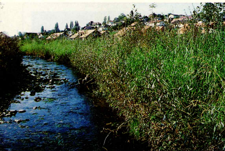
ard (14 octobre 1986), les berges sont consolidées. Le 25 août 1989 (à droite) une superbe végétation a stabilisé le cours de la rivière.
