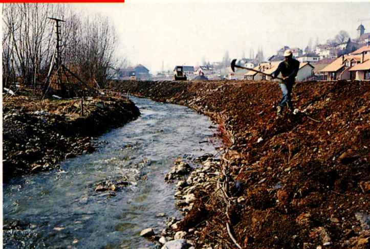
La Nesslera, près de Praroman (FR), et ses berges attaquées par l'érosion, en février 1986. A droite, les travaux en mars. Sept mois plus
