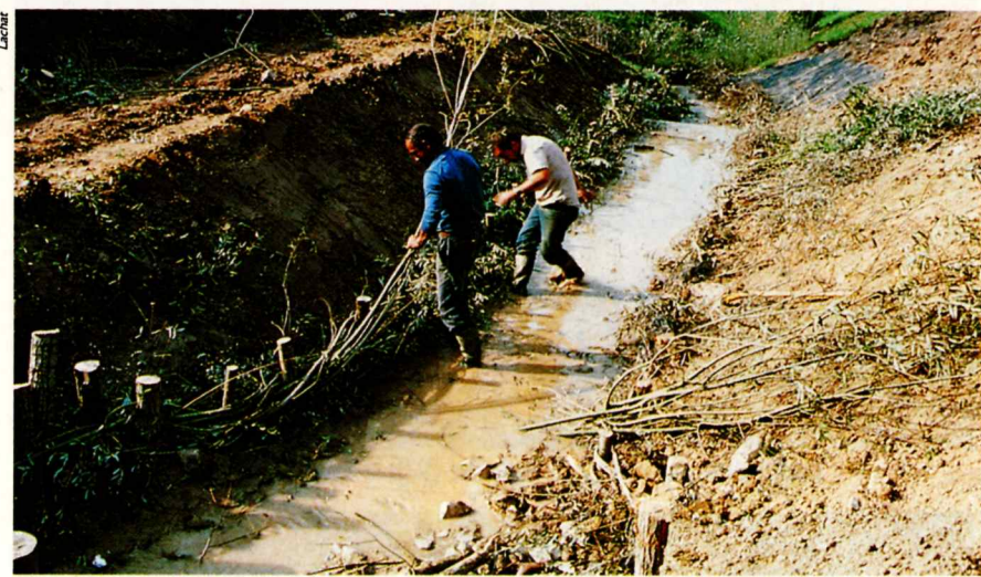
Mise en place d'un tressage sur le Châtelard (FR)
