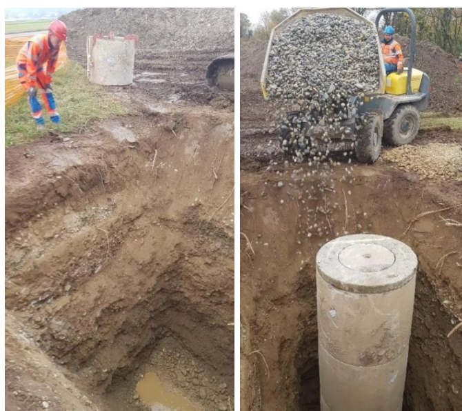
Figure 10 : Photographies du chantier de réalisation du puits d'infiltration
