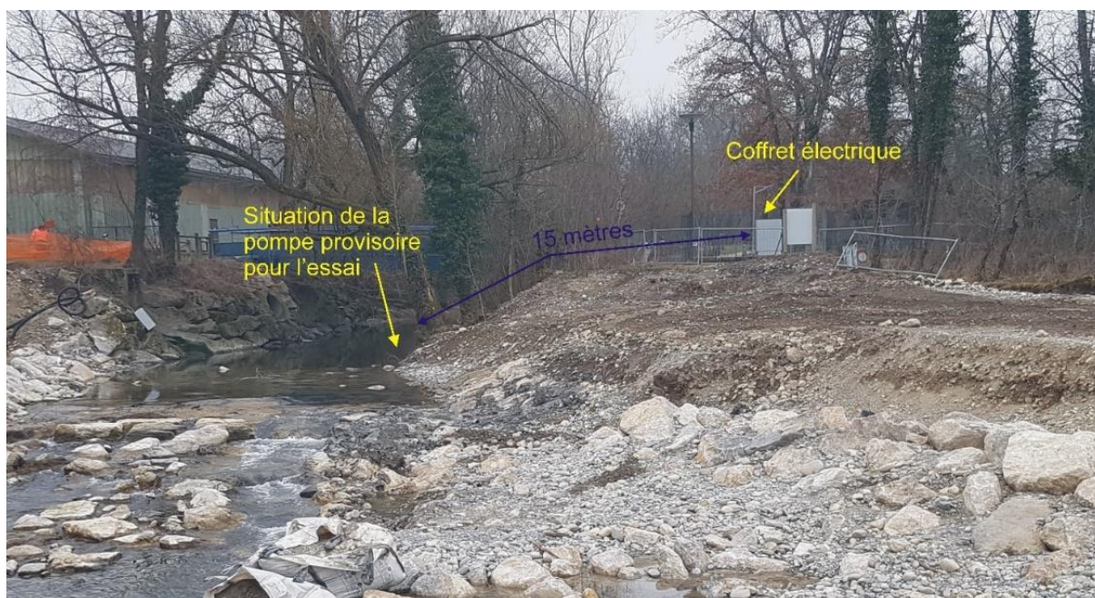
Figure 12 : Dispositif de prélèvement d'eau de l'Aire, à la frontière F-CH, pour la réalisation du test d'infiltration
