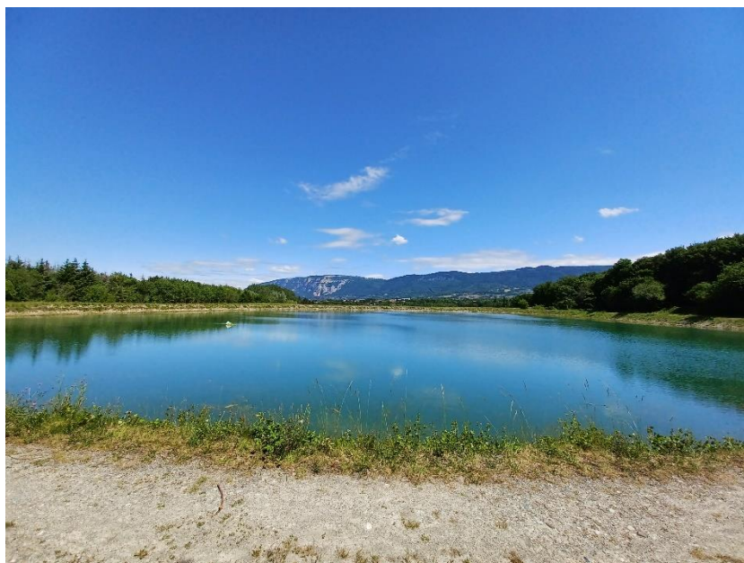
Figure 9 : vue de la retenue collinaire d'Ogny, alimentant le réseau d'irrigation agricole de la plaine de l'Aire
