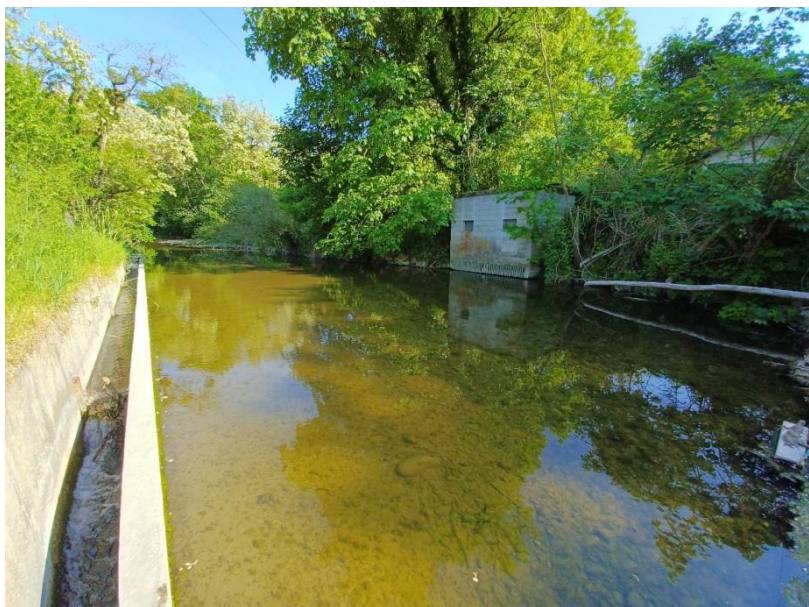
Figure 8 : vue de la station de pompage et de la passe à poissons
